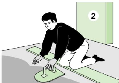
El tiempo de secado (de 2 a 4 horas) depende del espesor de la capa y de la temperatura ambiente. Esperar 24 horas antes de aplicar una segunda capa, si fuera necesario, o el nuevo revestimiento.
