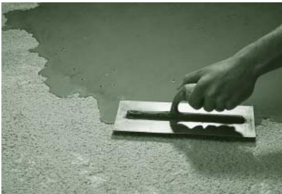
Los productos autonivelantes para alisar suelos sirven para corregir los defectos de nivel, tanto en soleras de hormigón, como en suelos revestidos de baldosas o de madera, antes de la instalación de un nuevo revestimiento. Estas pastas niveladoras se utilizan para formar una capa de hasta 10 mm de espesor sobre el antiguo suelo. Si el desnivel supera los 10 mm, habrá que corregirlo con mortero.
